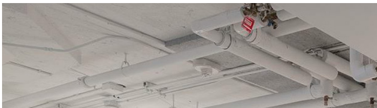
Lagi: lausvärvitud valgeks, osaliselt liimitud akustilised paneelid Ecophon Industry Modus TAL valge (1200x600)
