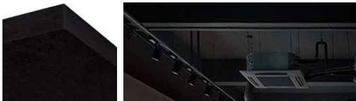
Lagi: lausvärvitud mustaks, osaliselt liimitud akustilised paneelid Ecophon Industry Modus TAL must (1200x600mm)
